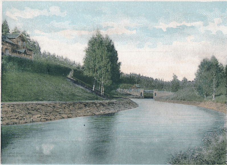
Saima kanal. Slussen vid Lauritsala. Saimaan kanava. Sulku Lauritsalan luona.
